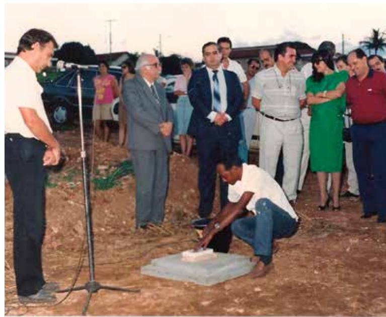
Lançamento da pedra fundamental da sede da AEASC em 1989
